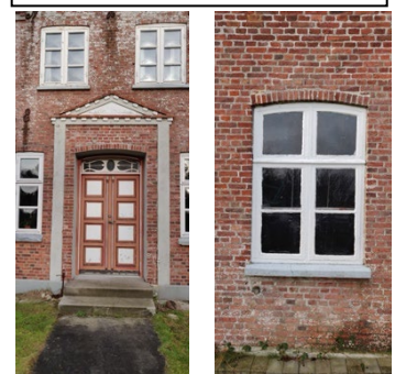
Foto 2: Hoveddør der er i tråd med de ældste Rømøhuses oprindelige døre (OBS: Gælder ikke for matrikel 12 og 998 Kongsmark, Rømø). Foto: Tegnestuen Stedse
